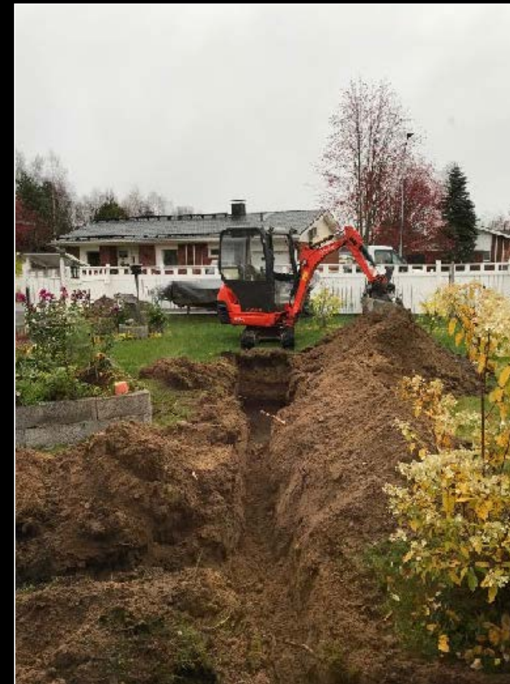
pihalle kaivettavien salaojavetojen sijainti
